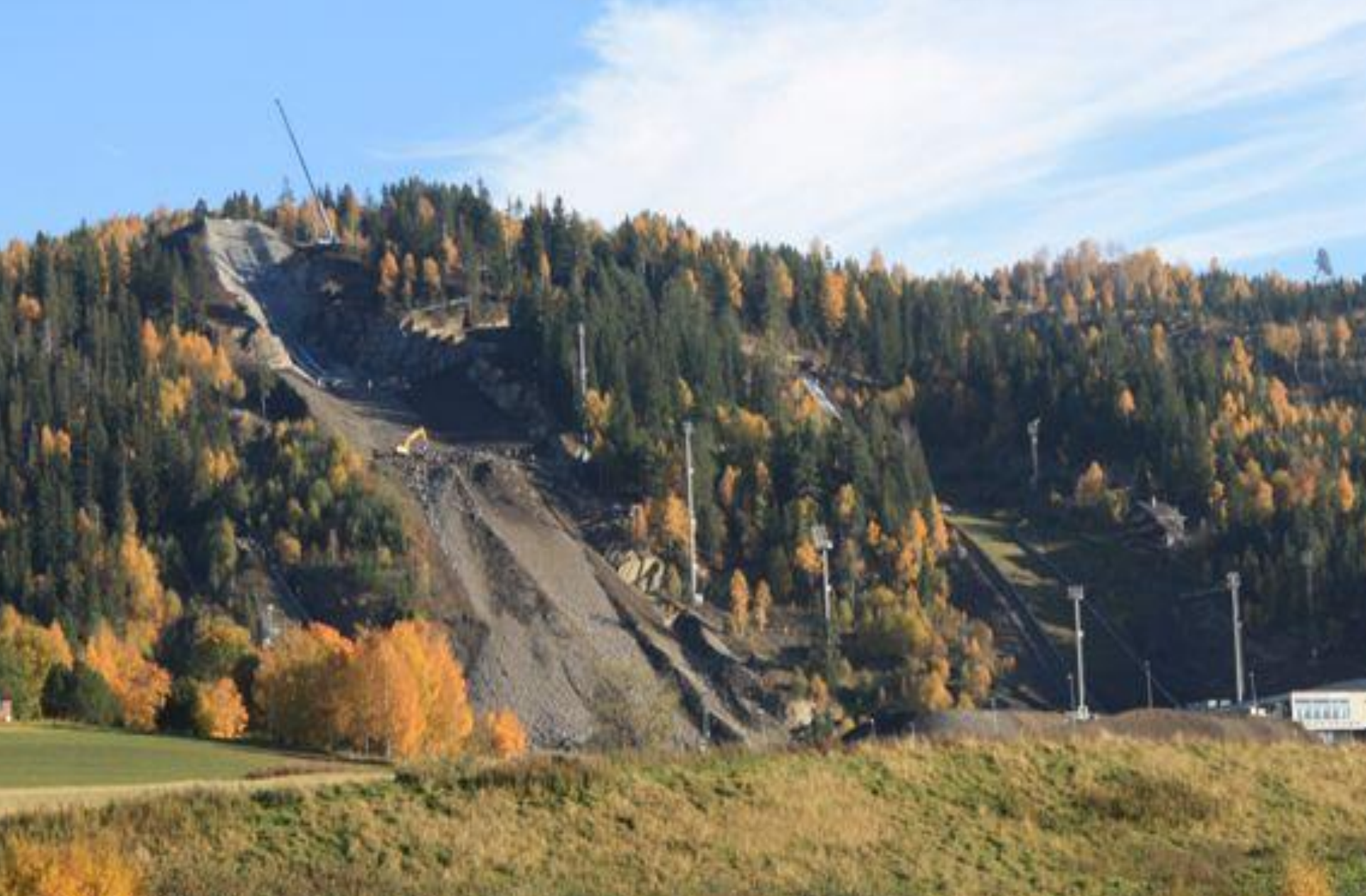
Vikersund Skiflyvningsbakke. Under ombygging, tydeligvis.
